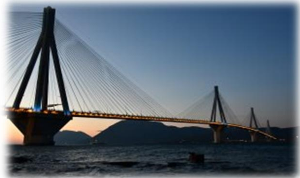
Εικ. 26: Γέφυρα Ρίου -Αντιρρίου
