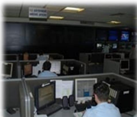
Εικ.21: Τηλεφωνικό Κέντρο Διεύθυνσης Άμεσης Δράσης Αττικής
